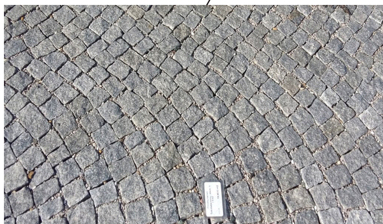
Kamenná dlažba kombinovaná so svetlých žulových kociek
