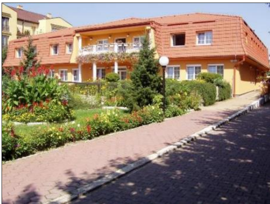
Obr. 39 Budova Spoločensko-relaxačného centra, Milosrdenstva 4
